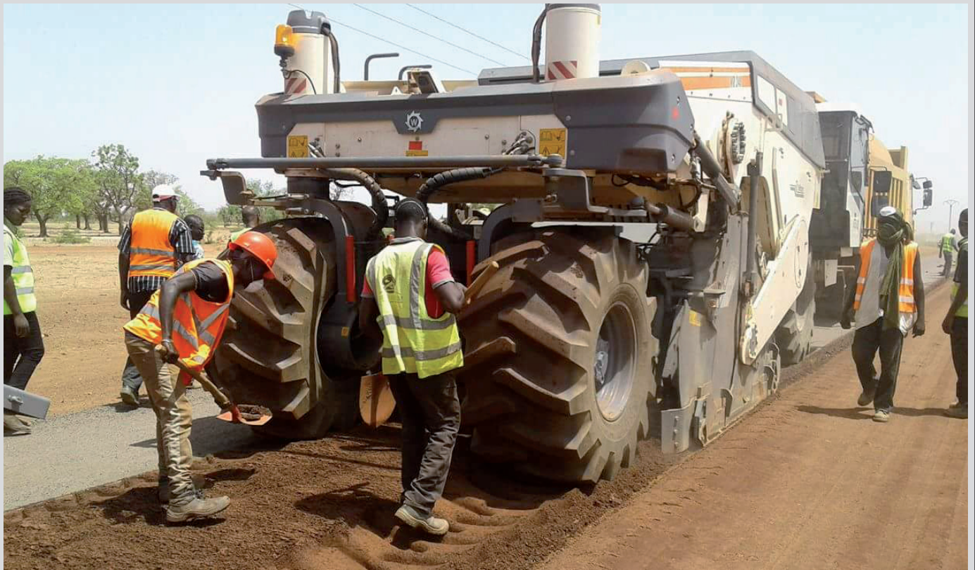
Travaux de chantier de l'échangeur du Nord.
