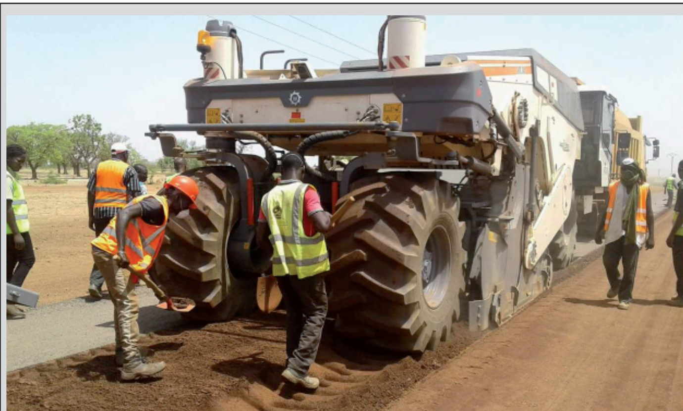
Travaux de chantier de l'échangeur du Nord.
