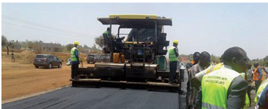
Travaux de la route Kongoussi-Djibo.
