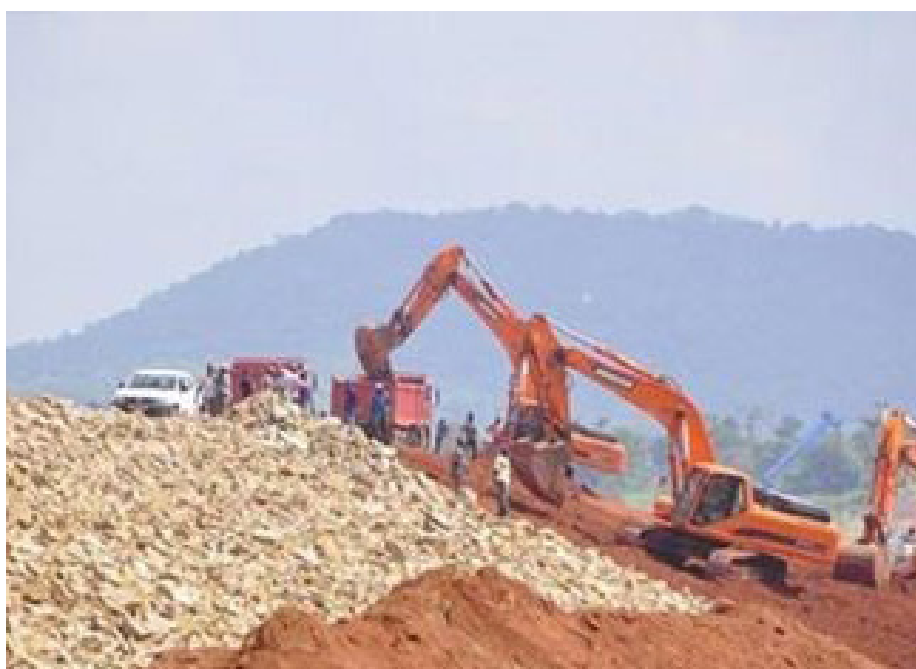
Le barrage de Samandéni en chantier.
