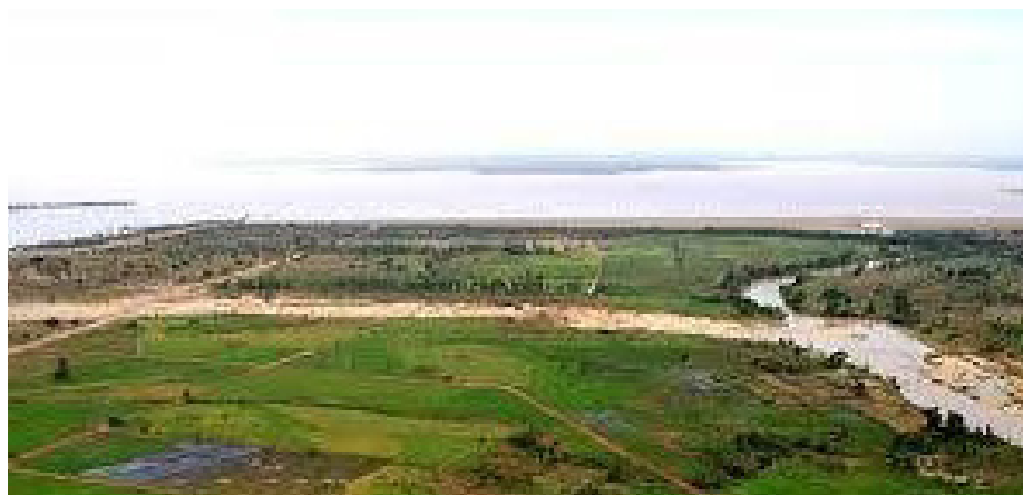
Chantier du barrage.
