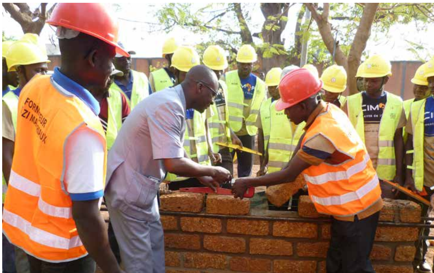
Le Maire Fiacre Kambou lançant officiellement les travaux du chantier école.
