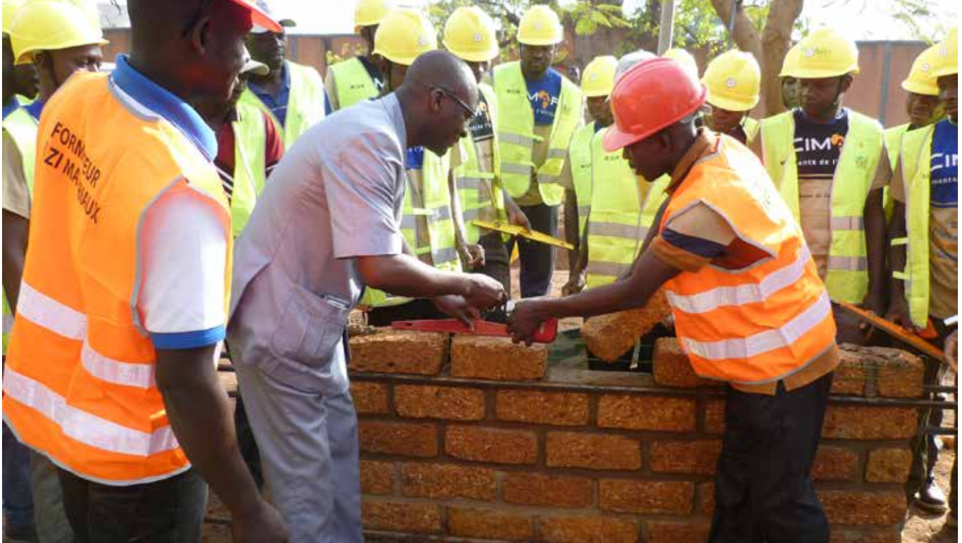
Le Maire Fiacre Kambou lançant officiellement les travaux du chantier école.
