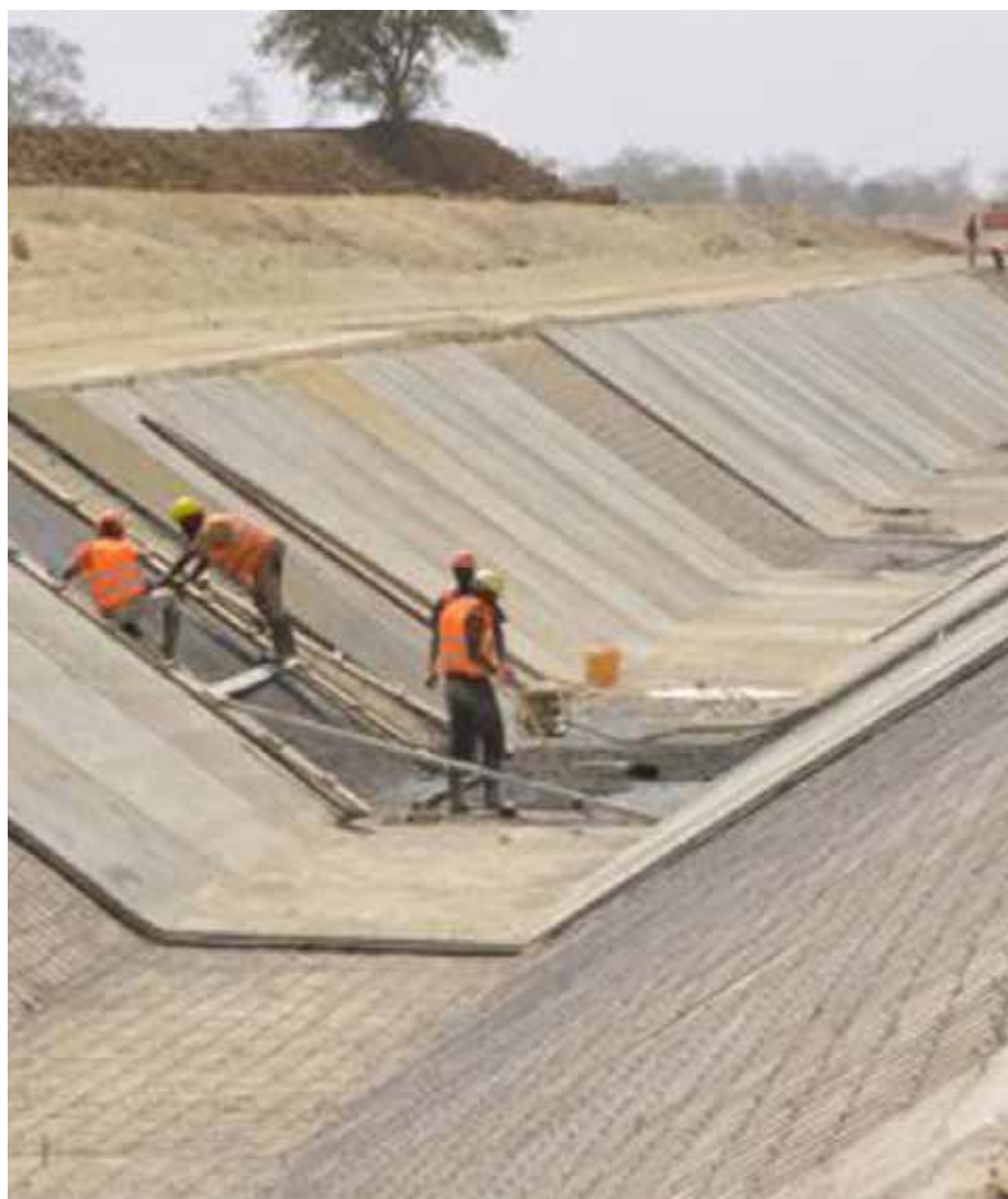
Une vue du canal principal.
