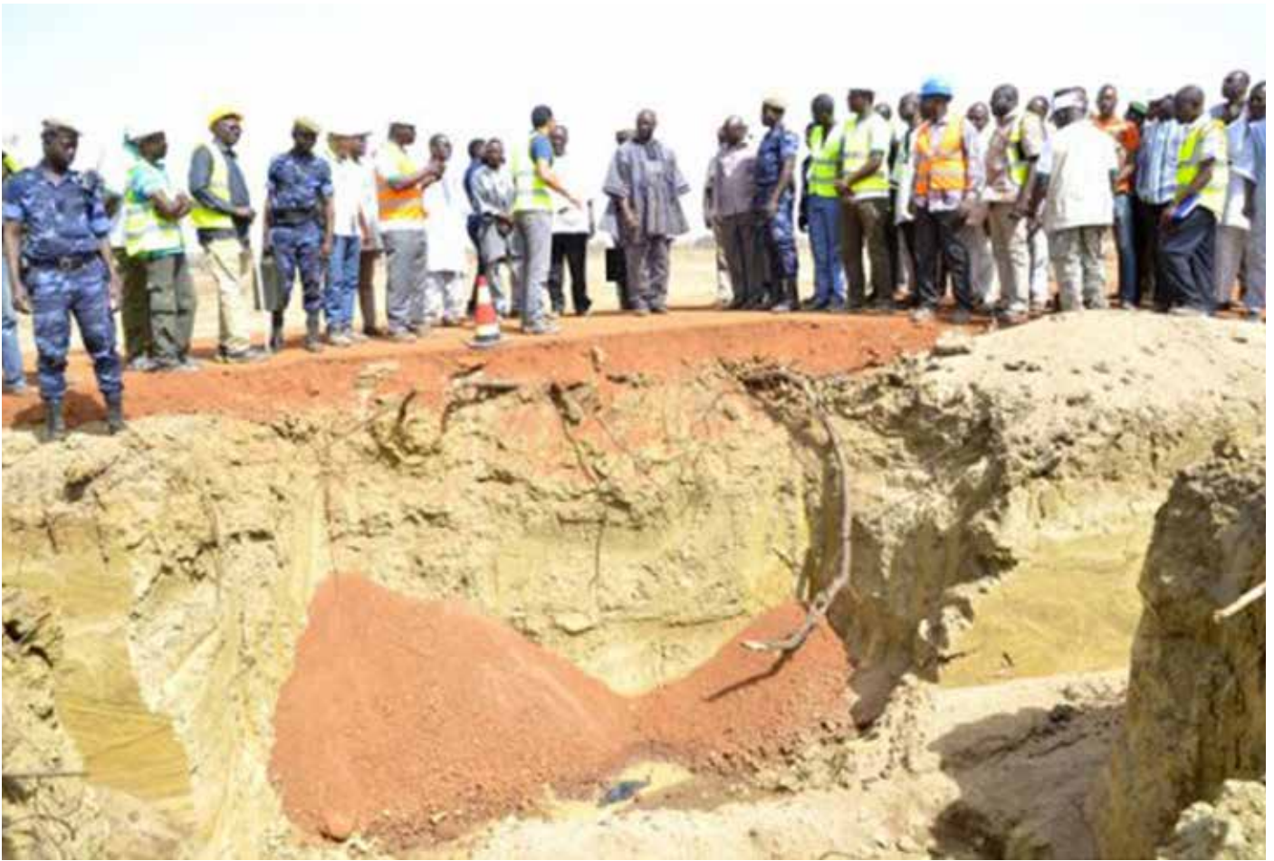
Le Premier Ministre et ses collaborateurs visitent le chantier.
